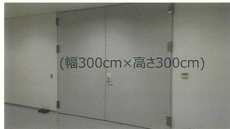
舞台搬入口(舞台搬入用EV正面)
